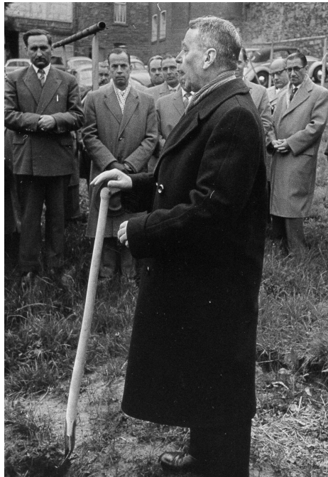
Der „Erste Spatenstich“ zum „neuen“ Haus Marienhof–Prälat Weißkichel-
