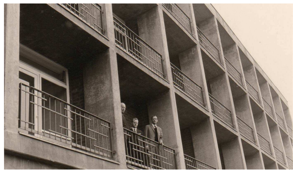
und vor 1988,/ vor dem Umbau /
