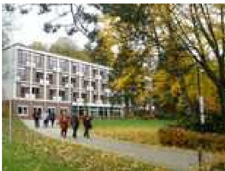
Haus Marienhof->Nach dem Umbau /heutiger Stand
