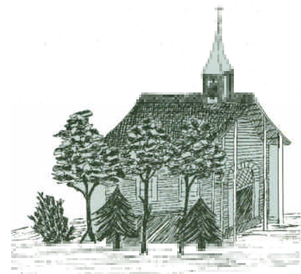
Bild 3 Alte Birkhof - Kapelle Entwurf 1892, wurde 1893 durch Tagebau zerstört
